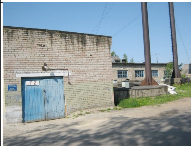
Рисунок 1.2.3 – Котельная с. Шунга. Здание котельной
