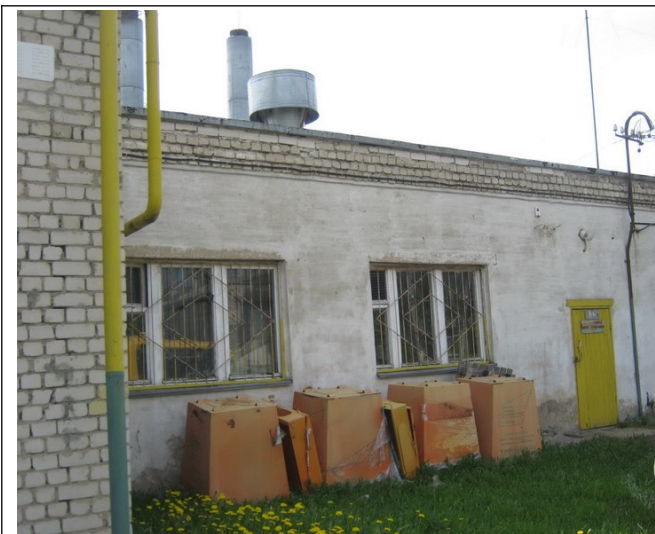
Рисунок 1.2.1 – Котельная школы с. Шунга. Здание котельной
