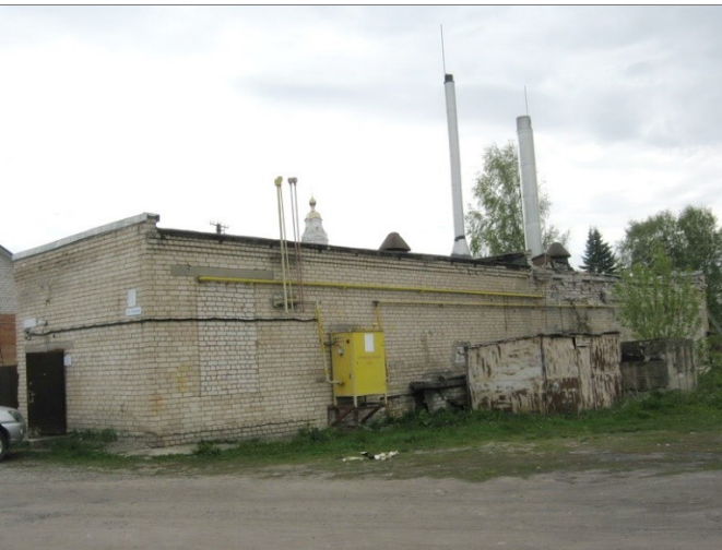
Рисунок 1.2.11 – Котельная с. Яковлевское. Здание котельной.
