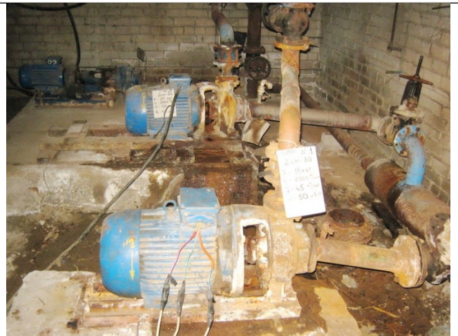
Рисунок 1.2.10 – Котельная с. Саметь. Сетевые насосы.
