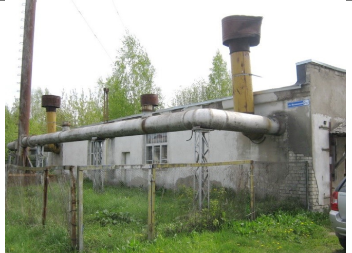
Рисунок 1.2.8 – Котельная с. Саметь. Здание котельной.
