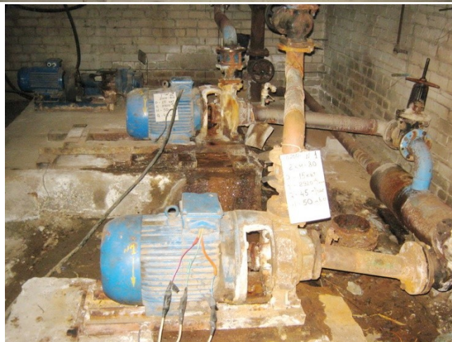
Рисунок 2.1.9 – Котельная с. Саметь. Котлы Факел Г.
