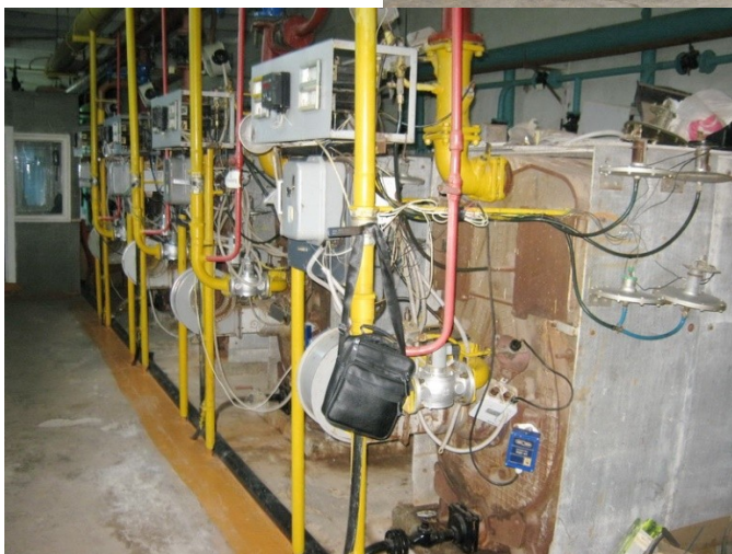
Рисунок 2.1.19 – Котельная с. Петрилово. Здание котельной.
