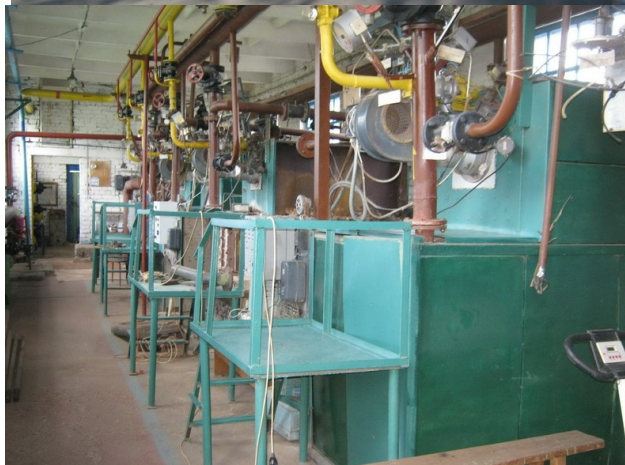
Рисунок 2.1.3 – Котельная с. Шунга. Здание котельной
