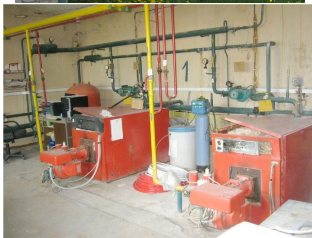
Рисунок 2.1.1 – Котельная школы с. Шунга. Здание котельной
