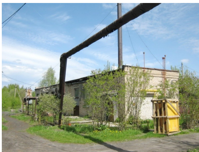
Рисунок 2.1.18 – Котельная д. Некрасово. Сетевые насосы.
