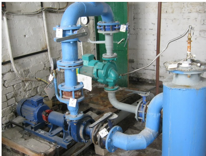
Рисунок 2.1.11 – Котельная с. Яковлевское. Здание котельной.
