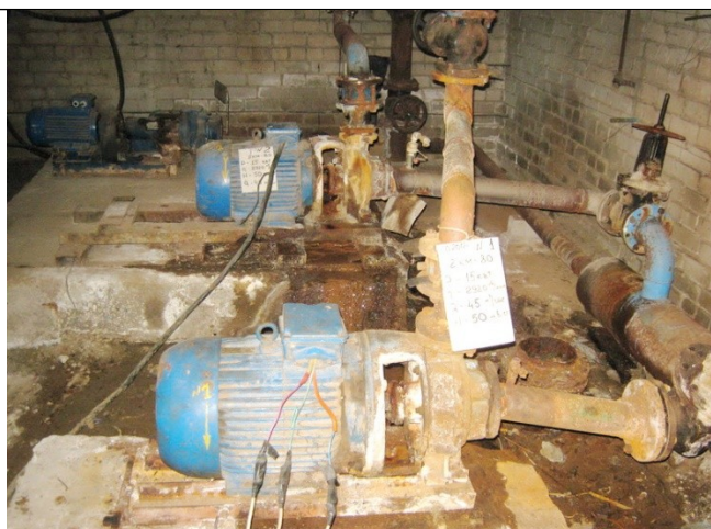
Рисунок 2.1.10 – Котельная с. Саметь. Сетевые насосы.
