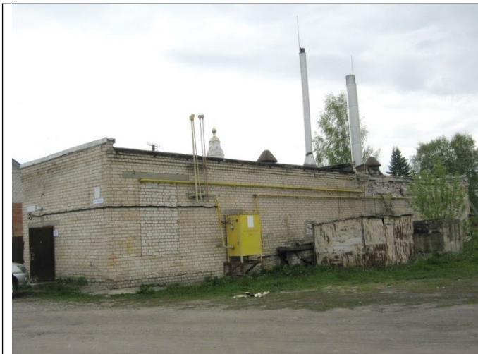
Рисунок 2.1.11 – Котельная с. Яковлевское. Здание котельной.
