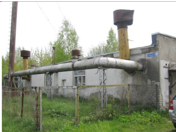
Рисунок 2.1.8 – Котельная с. Саметь. Здание котельной.
