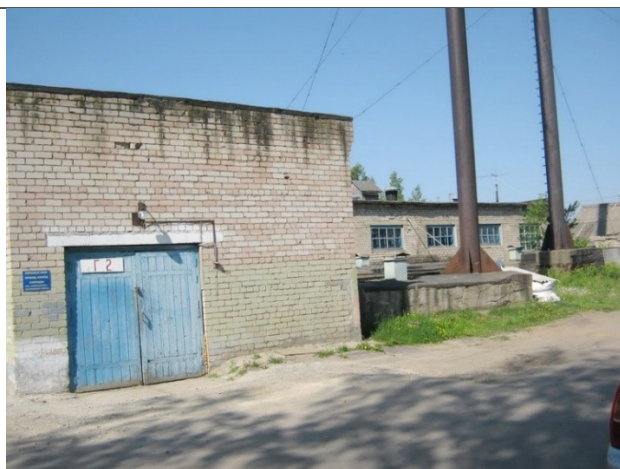
Рисунок 2.1.3 – Котельная с. Шунга. Здание котельной
