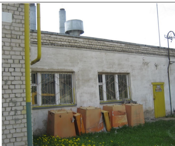
Рисунок 2.1.1 – Котельная школы с. Шунга. Здание котельной
