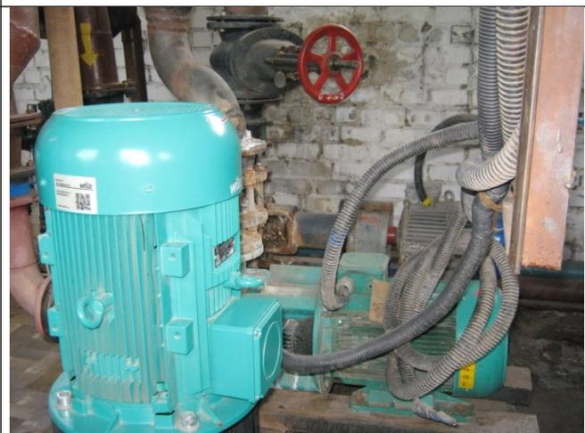
Рисунок 1.2.5 – Котельная с. Шунга. Сетевые насосы
