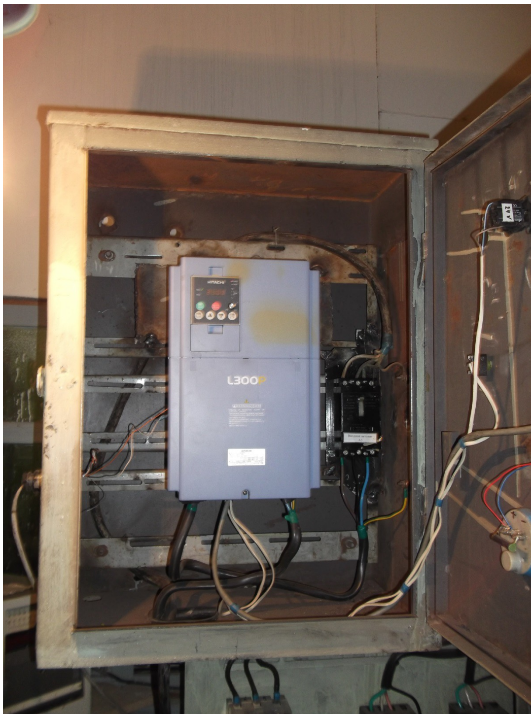
Частотный преобразователь Рис. 4 – Станция водоснабжения с. Яковлевское
