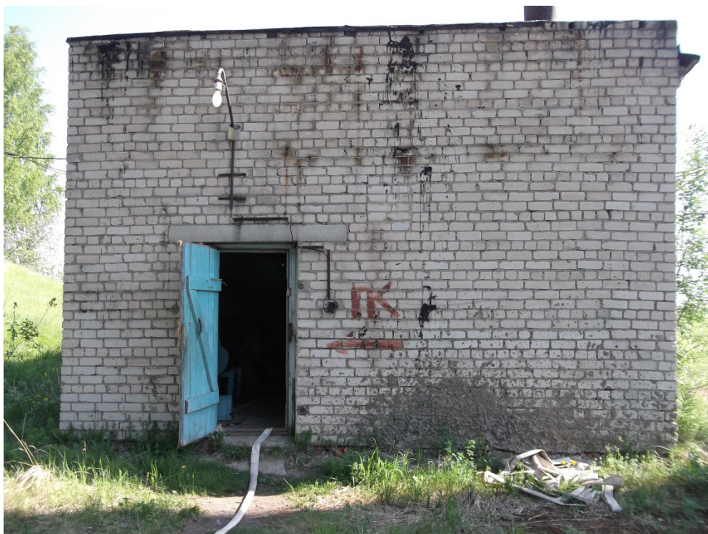
Станция обезжелезивания (постройка) Рис. 1 – Станция водоснабжения с. Яковлевское
