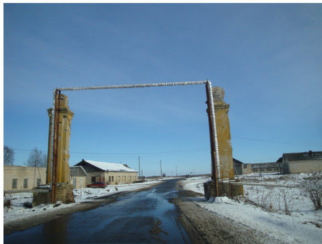
Фото 1.2.8 – участок теплотрассы с. Саметь
