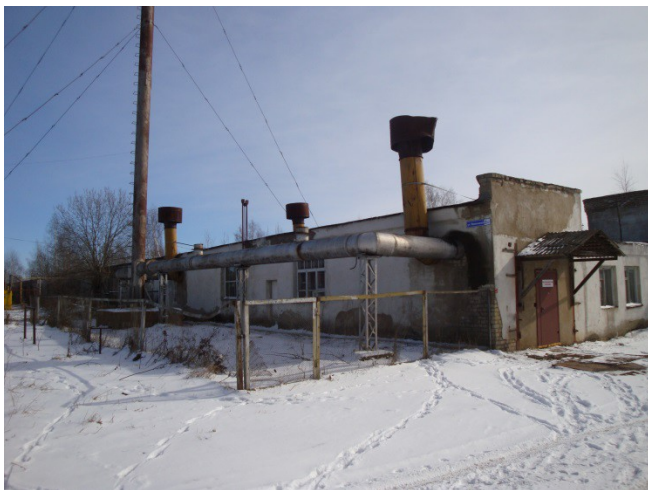
Фото 1.2.1 – котельная с. Саметь, общий вид
