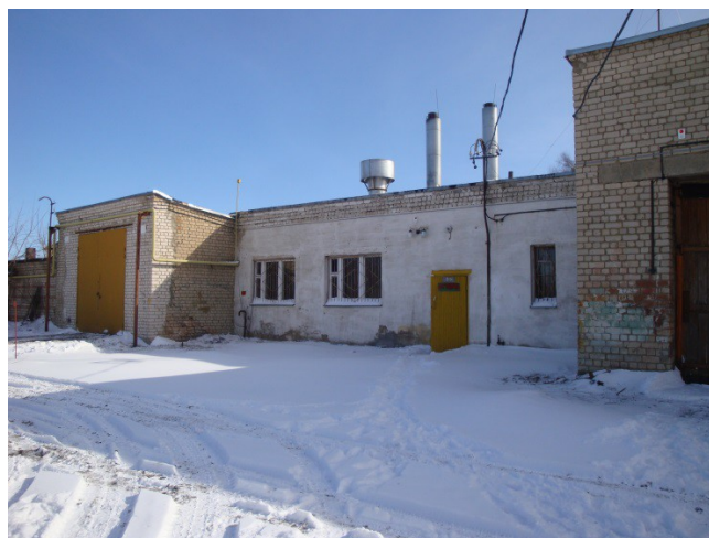
Фото 1.2.10 – котельная с. Шунга, общий вид
